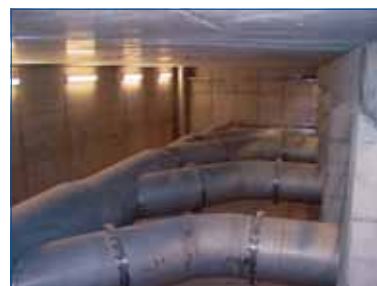
Рис. 4.1.1.2с: Врезка отдельных напорных трубопроводов в коллектор по потоку
