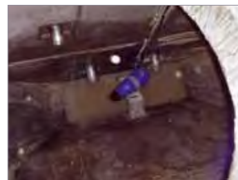
Рис. 5.7: Мешалка с погружным двигателем в зумпфе
