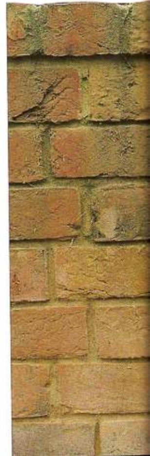
Кирпичная стена, выложенная двусторонней фламандской кладкой
