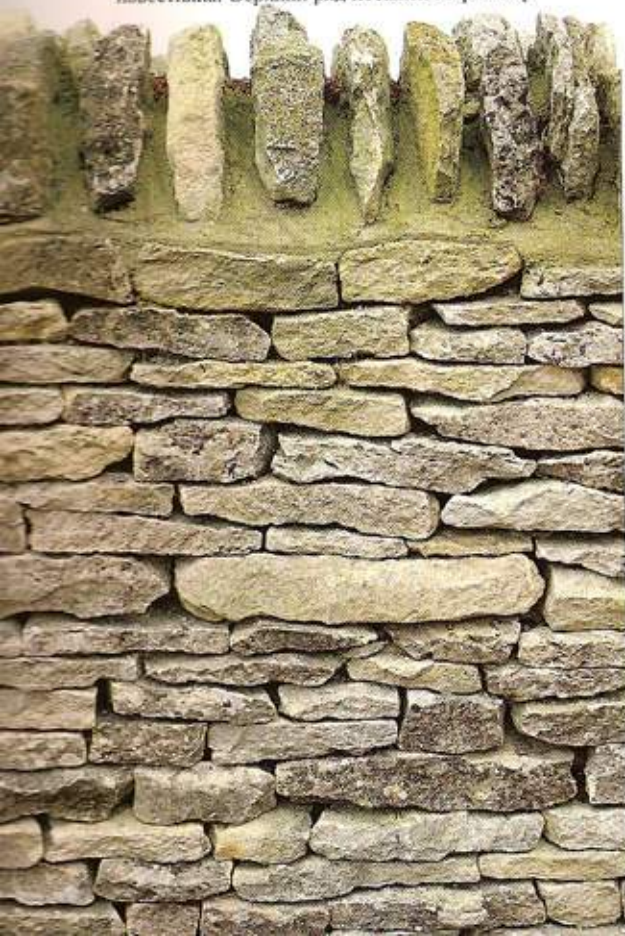
Стена, выложенная ровными рядами из сухого известняка. Верхний ряд посажен на раствор
