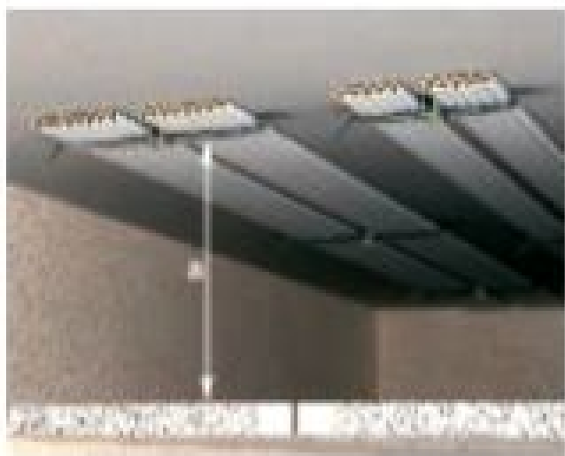
а) б) Рисунок 4.10.3 - Прокладка кабелей над огнестойким непроходным подвесным потолком с помощью: а) кабельных зажимов; б) групповых креплений-захватов
