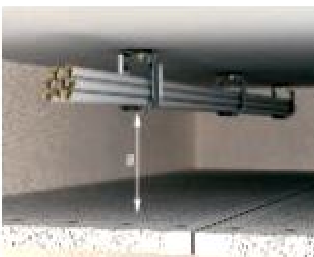
а) б) Рисунок 4.10.3 - Прокладка кабелей над огнестойким непроходным подвесным потолком с помощью: а) кабельных зажимов; б) групповых креплений-захватов
