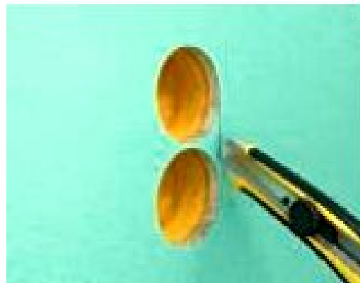
Рисунок 4.9.1 – Высверливание гнезда под установку установочных коробов
