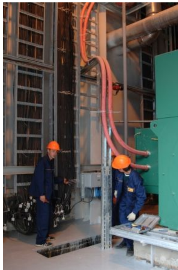
Рисунок 4.7.12 - Монтаж электропроводок на лотках
