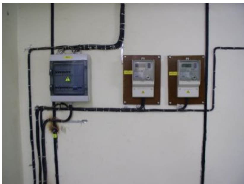
Рисунок 4.3.3 - Электропроводки открыто непосредственно по строительным основаниям
