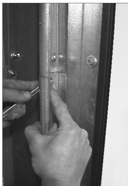
14. Прикрепите вертикальную направляющую (левую) обратно к углу.
