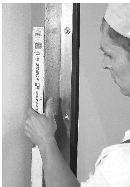
13. Проверьте вертикальный уровень угла.
