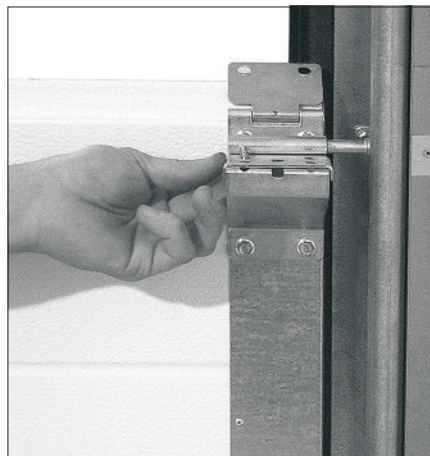
24. Отрегулируйте кронштейны для роликов.
