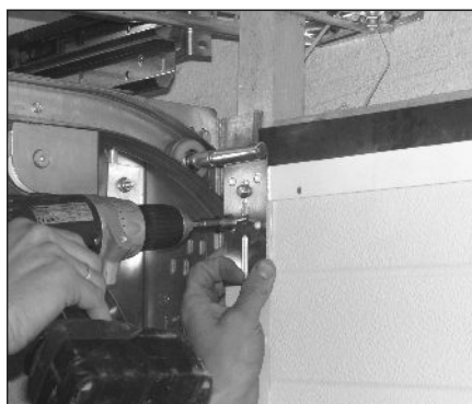
27. Закрепите верхние кронштейны для роликов с обеих сторон.
