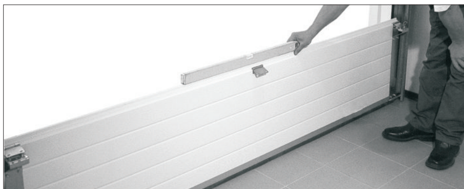
22. Установите в проем нижнюю панель. Выровняйте ее по уровню.
