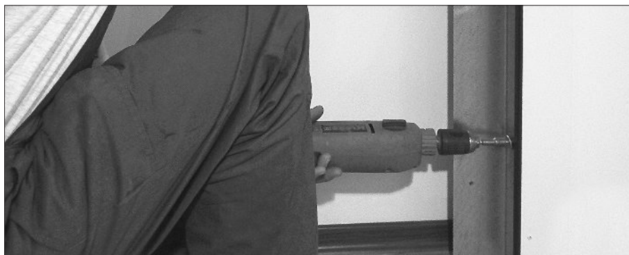
12. Совместите край угла с отметкой 55L а верх угла с отметкой TL. Закрепите угол к стене.
