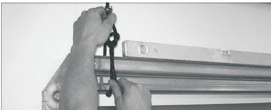
16. Временно свяжите концы направляющих. Для правильной установки направляющих используйте уровень.
