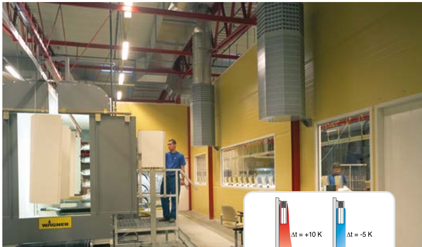
Swegon Booster - диффузор смешивающей и вытесняющей вентиляции
