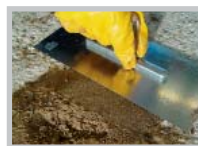
Ремонт (шпатлевание) поврежденных участков и выбоин
