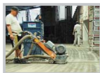
Фрезеровка (для удаления непрочных слоев)
