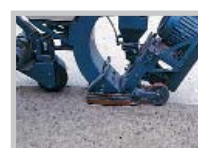
Дробеструйная обработка (для вскрытия пористой структуры основания)
