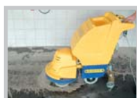
Очистка, например чтобы очистить основание с низкой абсорбирующей способностью
