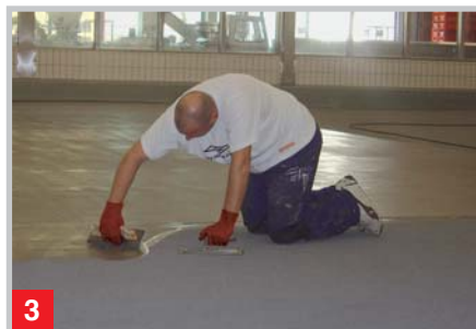
Суббота, полдень: Наносится первый базовый слой.
