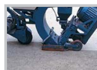
Дробеструйная обработка, для открытия пор основания
