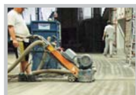
Фрезерование, для удаления слабых поврежденных слоёв
