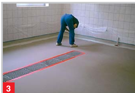
Четыре часа спустя: нанесение заключительного запечатающего слоя.
