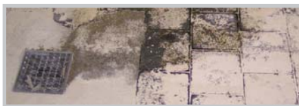
Поврежденные швы являются идеальной поверхностью для развития бактерий
