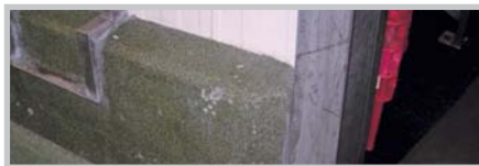
Повреждения от ударов (например из-за интенсивного движения автопогрузчиков) угрожают гигиене.
