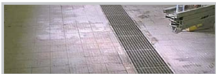
Хорошие условия для размножения микроорганизмов: сколотые края водоотводных желобов
