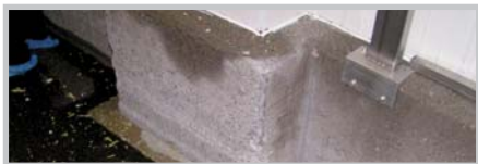
Прямая противоположность герметичному полу: пористая область примыкания стен к полу
