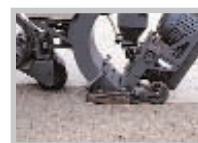
Дробеструйная обработка (для вскрытия пористой структуры основания)
