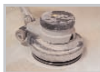
Шлифование (на мягких основаниях или для выравнивания шероховатостей основания)
