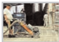
Фрезерование (для удаления слабых поврежденных слоев)
