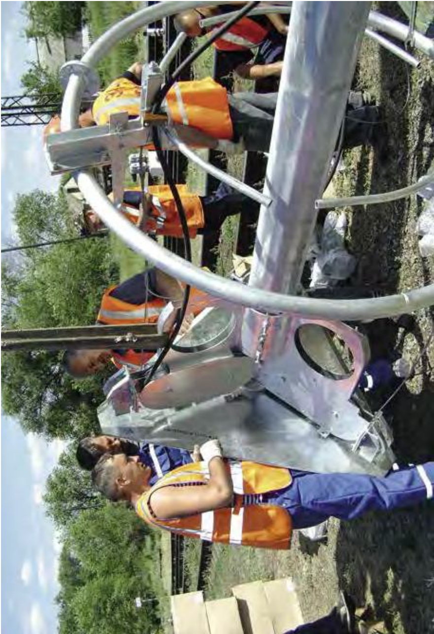
Монтажный комплект Используется при монтаже мачт различного назначения
