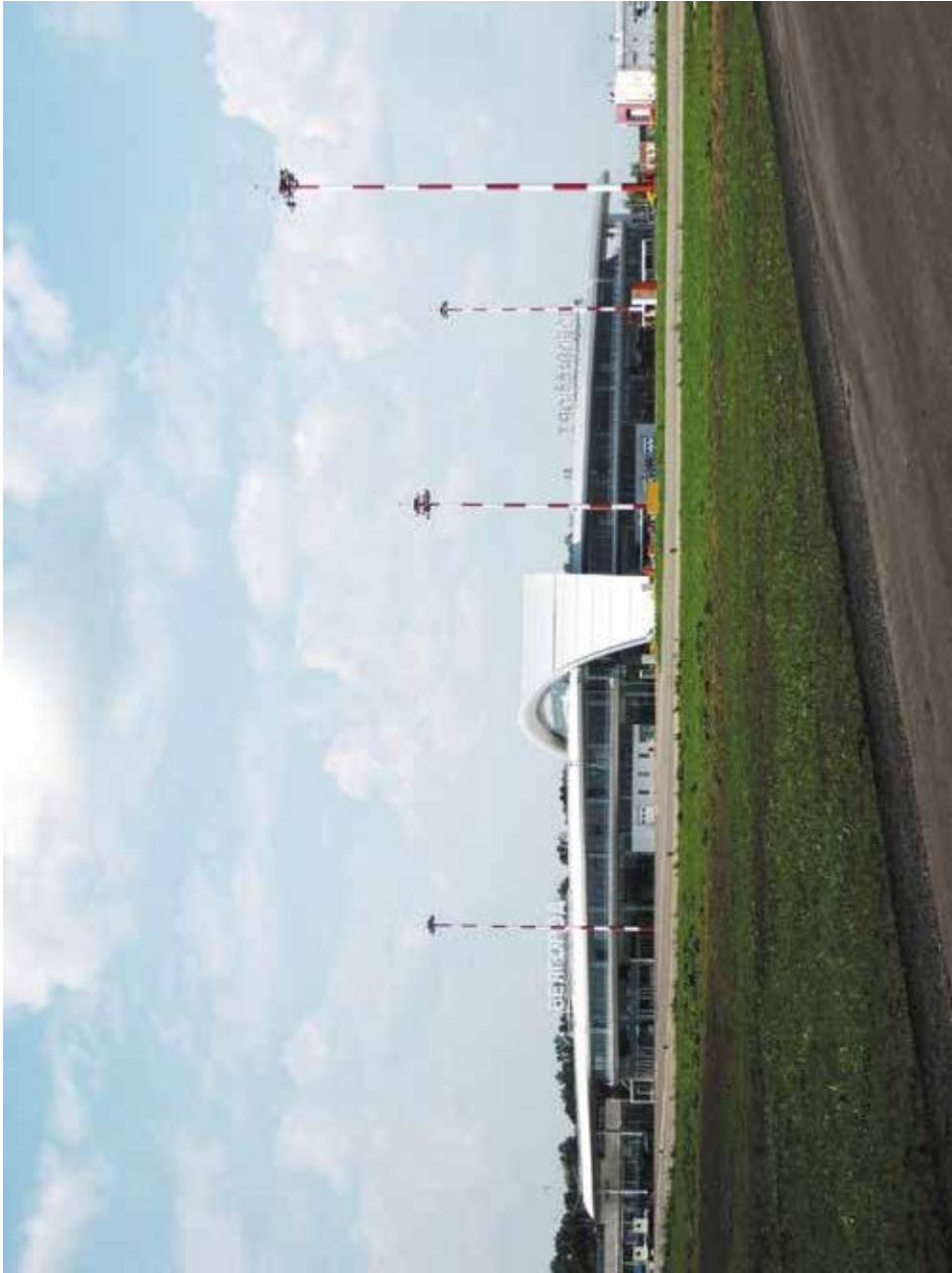
Функциональное освещение перронов аэропорта Белгород. Мачты специальные с дневной маркировкой и аварийными прожекторами и огнями ЗОМ.
