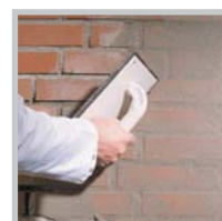
Нанесение шламового раствора с разглаживанием
