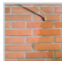
Дополнительная пропитка продуктом Remmers Funcosil SNL
