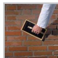
Заключительная очистка на ранних стадиях отверждения
