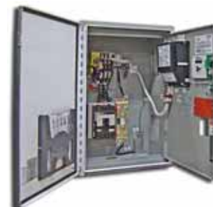
Рис. 17: Корпус типа 1 для устройства ASCO Серии 300 SE на 200 ампер с выключателями источника питания
