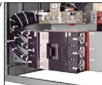
Рис. 12: Перемычки отключения заземления и нейтрального провода
