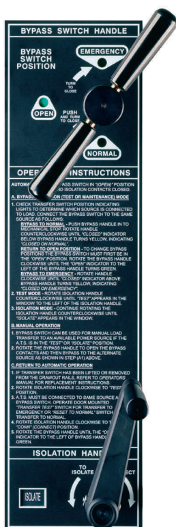
Органы управления байпасом и гальванической развязкой и инструкции по их эксплуатации
