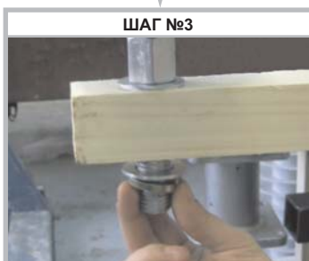
Установите плоскую и пружинную шайбу на резьбовую часть изолятора
