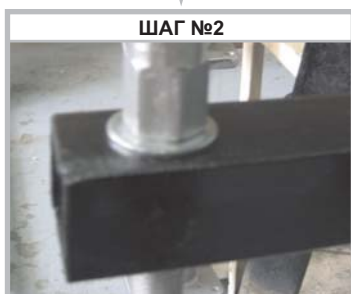
Установите изолятор с шайбой в отверстие траверсы
