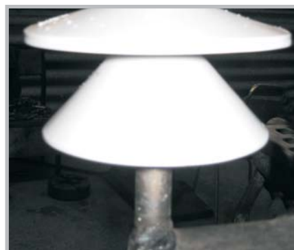
Вид установленного изолятора на траверсе
