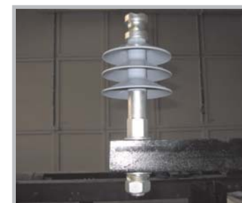
Вид установленного изолятора на металлической прямоугольной траверсе
