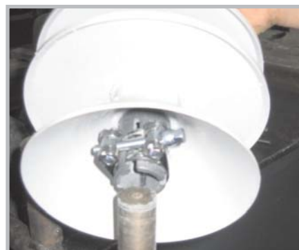
Штырь траверсы Ø22мм
