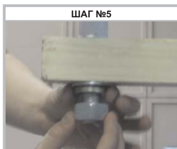
Установите гайку на резьбовую часть изолятора
