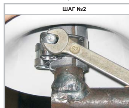
Затяните хомут изолятора на траверсе, ключом М8
