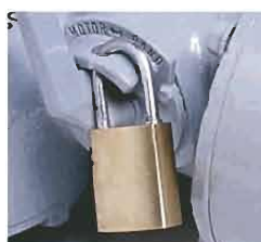
Блокировка рычага переключения
