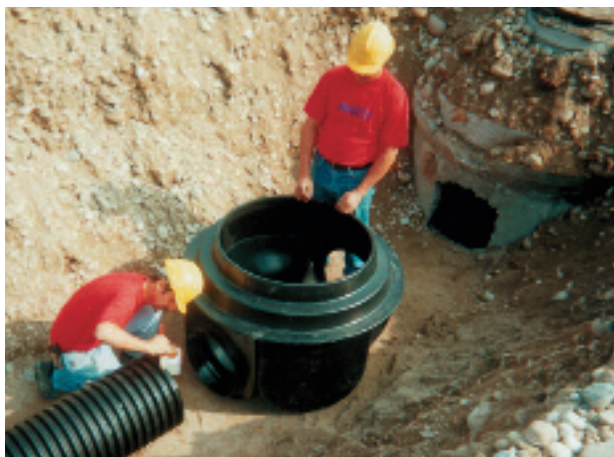
Рис.19. Соединение лотка ПЗ колодца с трубой
