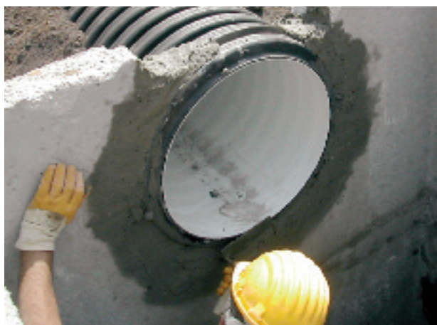
Рис. 20. Монтаж трубы КОРСИС в стенку бетонной камеры
