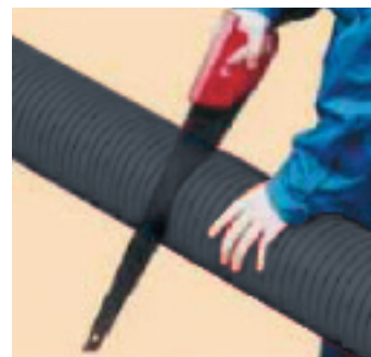
Рис. 14. Резка трубы КОРСИС
