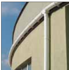
Применение специальных элементов - полукруглый желоб
