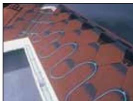
Греющий кабель на поверхности кровли
