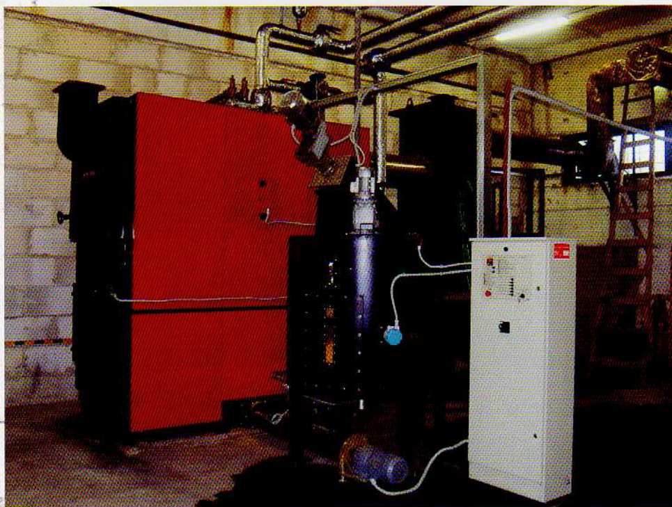
КОТЕЛЬНЯ С КОТЛОМ "KALVIS - 720M" И ПРОМЕЖУТОЧНОЙ ЕМКОСТЬЮ ТТ-0,7. ОБЩИЙ ВИД
