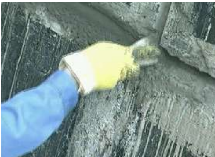
Рисунок 4.4 – Заделка трещин и швов при помощи шпателя
