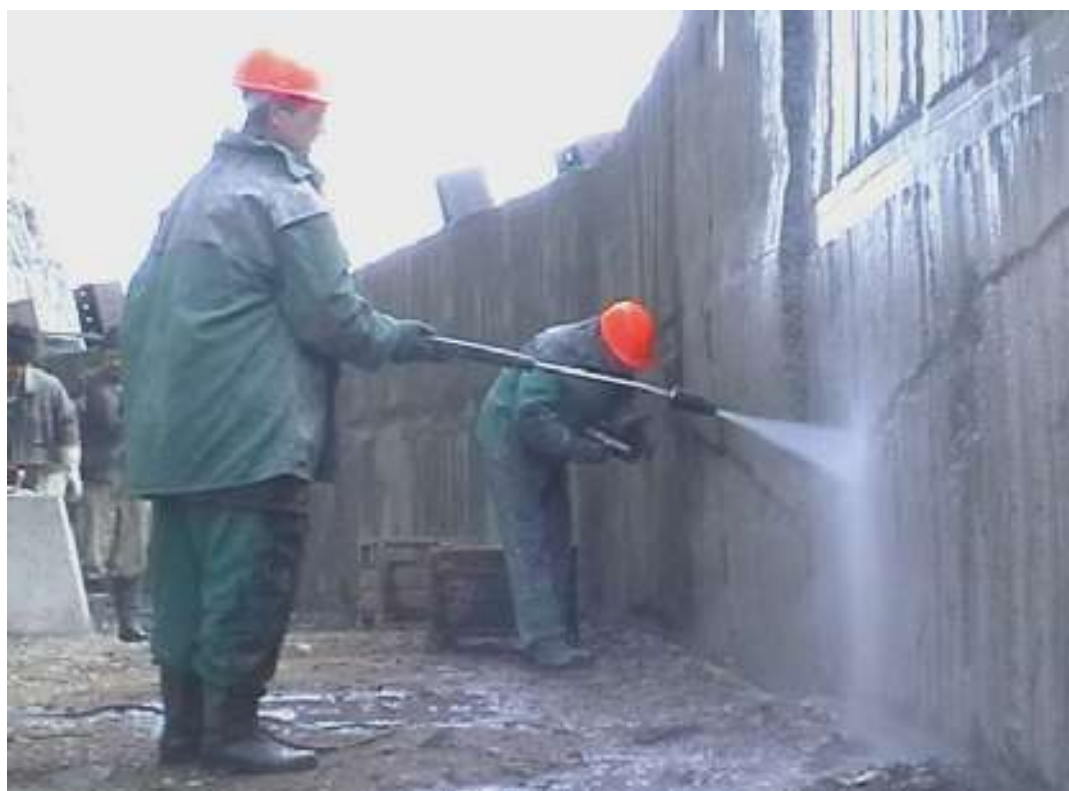
Рисунок 4.1 – Очистка и смачивание поверхности водой с помощью гидромонитора
