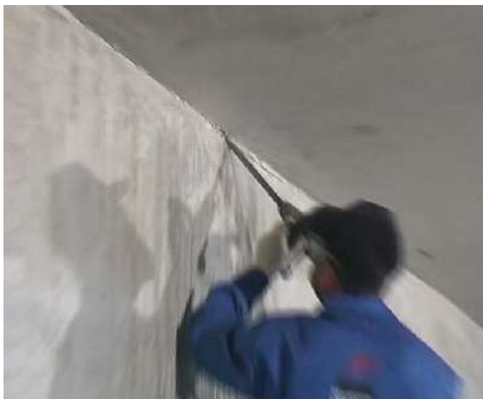
Рисунок 4.3 – Расшивка шва электроперфоратором
