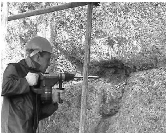
Рисунок 3. Разделка швов и трещин
