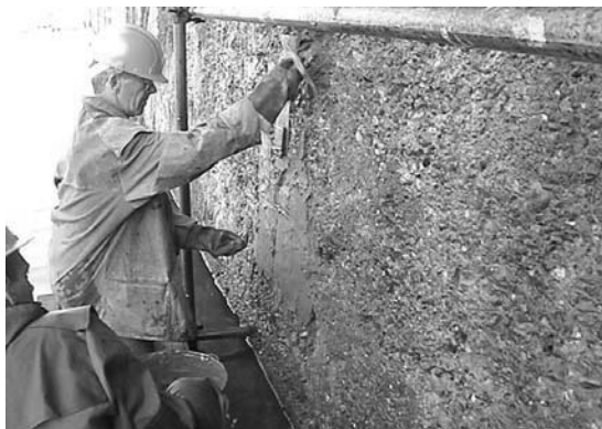
Рисунок 4. Заделка трещин и швов
