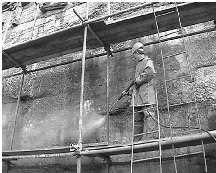
Рисунок 2. Смачивание бетонных поверхностей
