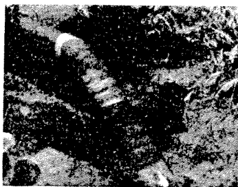
Рис. 224. Изоляция газопровода на выходе из-под воды
